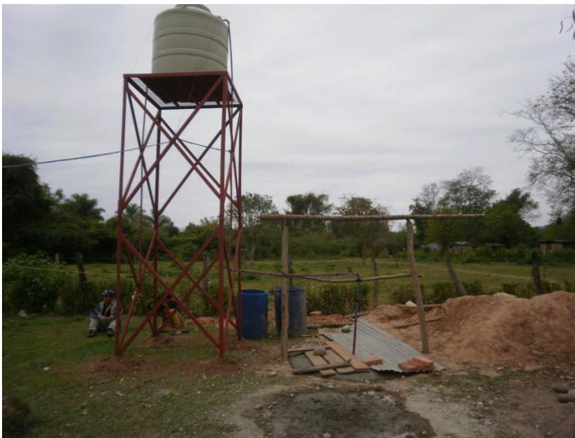
Tanque elevado y pozo (aún sin brocal)
